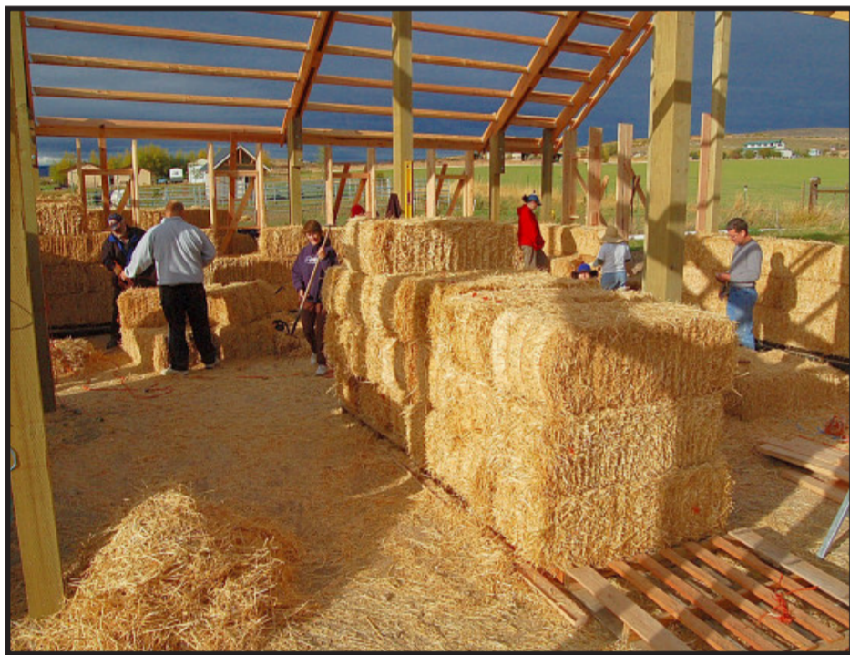
Stavba domu ze slaměných balíků Zdroj: https://celebratebig.com/pacific-northwest-ellensburg-strawbale-construction-workshop/
