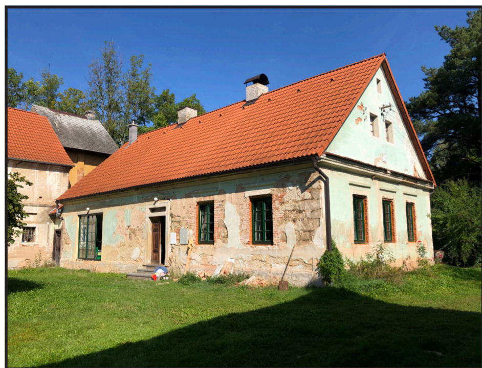
Fotografie objektu Zdroj: Vlastní zdroj
